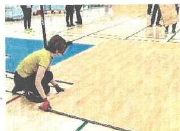
施工性に優れた移動式スポーツフロア「ボータブルフィット」の施工風景
